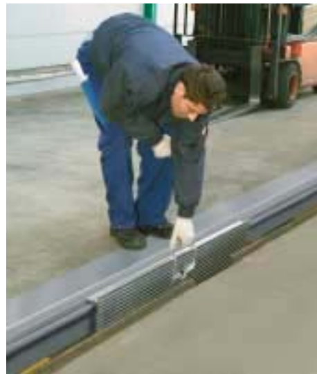
BB-Brücke aus der Führungsschiene herausheben.
